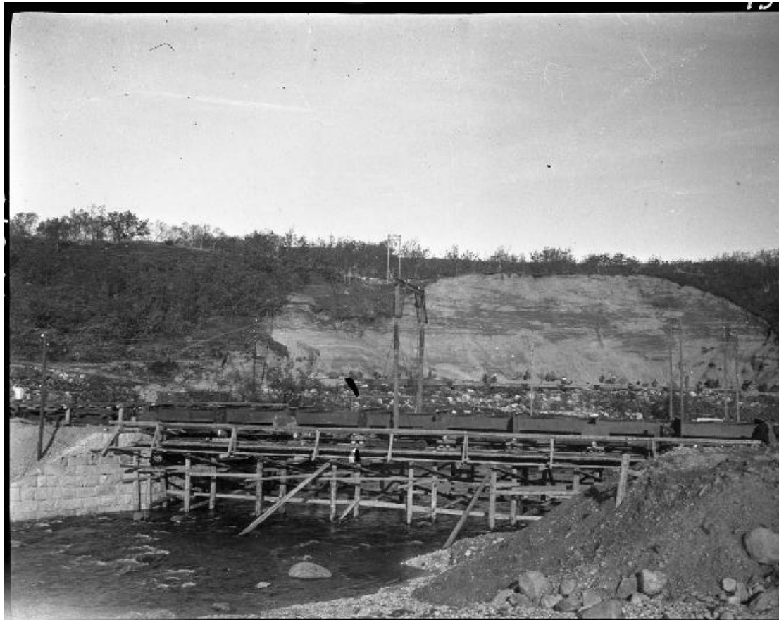
Figur 6.1: under bygging av Ålgårdbanen (Riksarkivet).
